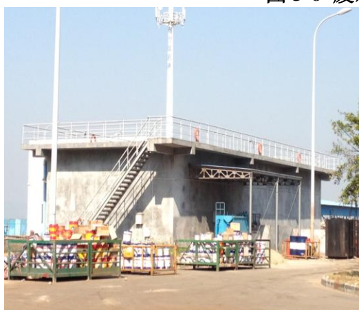
照片 3-3 废水处理站
