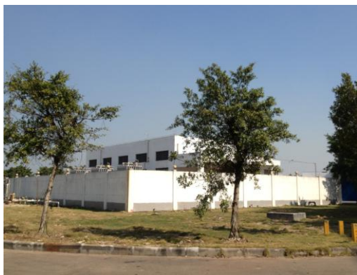
照片 8-12 地下应急池
