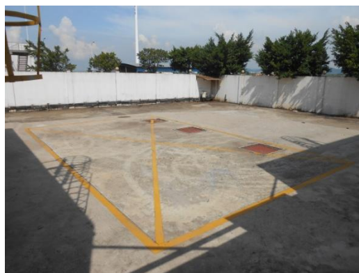
照片 8-13 消防水池
