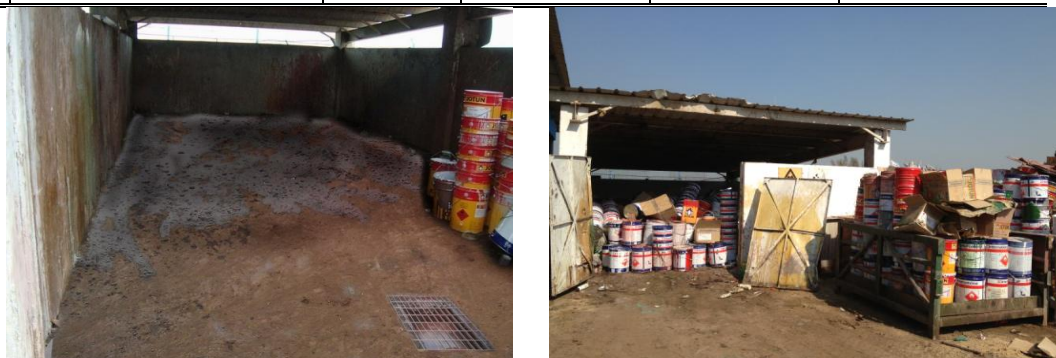
照片 8-5 危险废物暂存间
