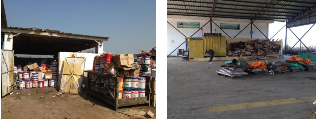
照片 3-5 固体废物暂存间
