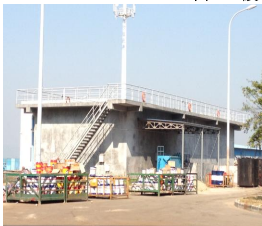
照片 3-3 废水处理站
